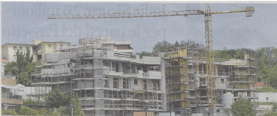
Le palazzine dell'ex immobiliare Elle acquistate a Pietralacroce dalla ditta Vignoni Srl di Osimo: i lavori di completamento sono stati avviati FOTO CARRETTA
