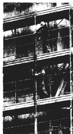
In cantiere. Nelle Marche ingegneri in campo per la sicurezza
